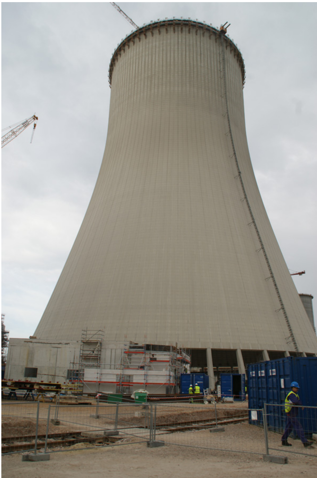
Budowa płaszcza chłodni rozpoczęła się w marcu 2014 roku. Jednym z
